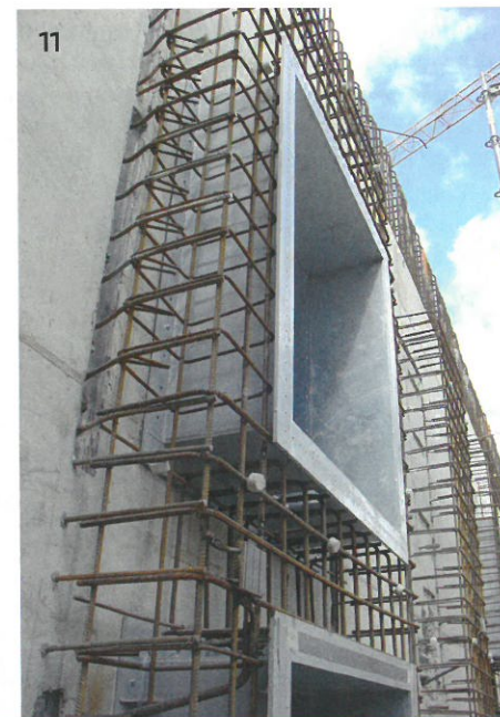
10, 11 > Pro každý prostup byly zhotoveny speciální ocelové pozinkované pažnice, které se vkládaly přímo do bednění před betonáž
