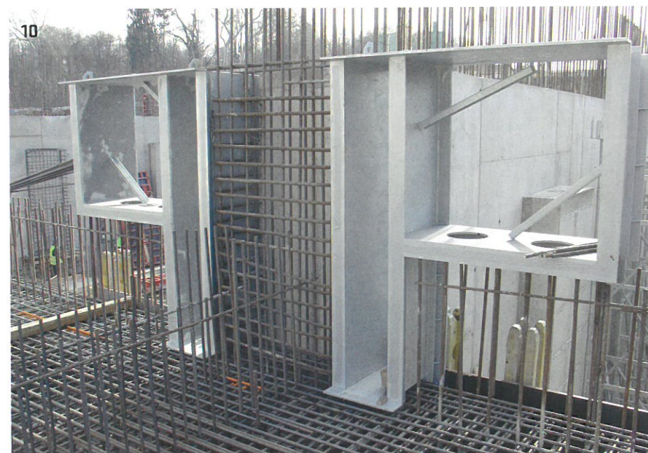
10, 11 > Pro každý prostup byly zhotoveny speciální ocelové pozinkované pažnice, které se vkládaly přímo do bednění před betonáž
