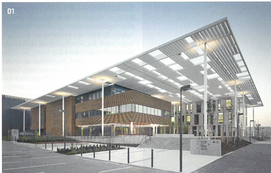
01 > Vstupní část laserového centra ELI – sjednocujícím elementem je ocelová stínicí konstrukce
