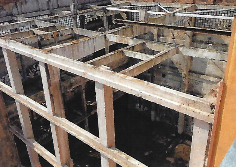
▲ Objekt E1 – původní stav železobetonového skeletu
