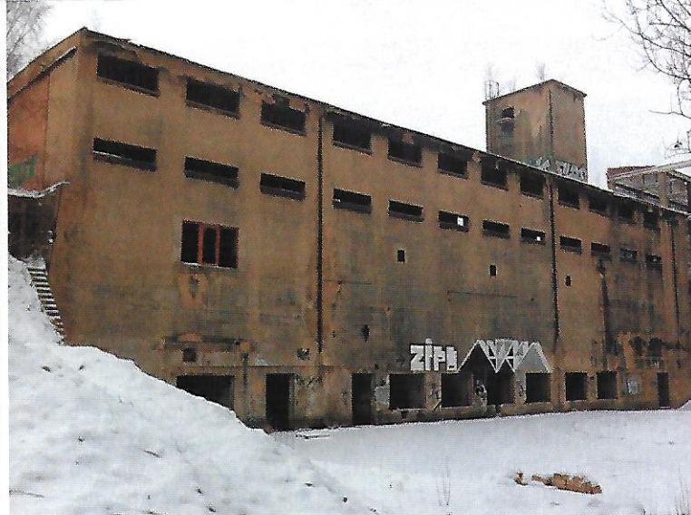
▲ Pohled na objekt E4 – před rekonstrukcí
