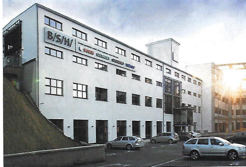
▲ Pohled na objekt E4 – po rekonstrukci
