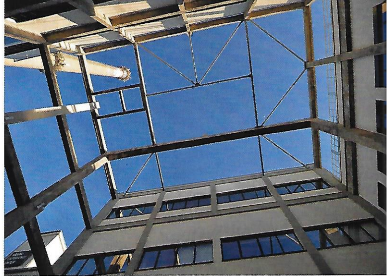
▲ Objekt E1 – průhled zachovaným skeletem, v současnosti vstupní atrium do administrativních budov
