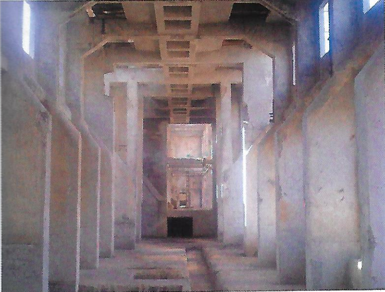
▲ Objekt E4 – stav po dokončení demoličních prací
