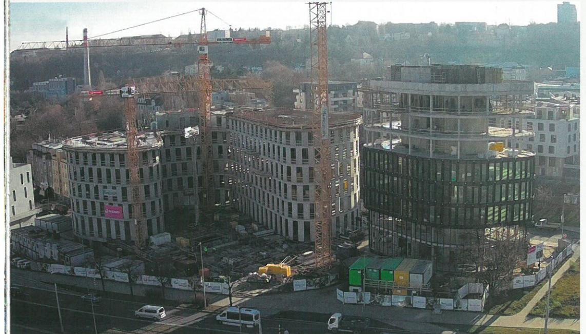
které působí jako jakýsi „otisk“ sousední budovy A, zároveň také velmi podporují vertikalitu této budovy, která je přitom jen o dvě podlaží vyšší než budova A. Veškerá okna jsou doplněna v modulu 2,70 m otevíravými šterbinami, čímž bylo jednoduše dosaženo možnosti přirozeného větrání v libovolné části jakkoliv členěného půdorysu.
