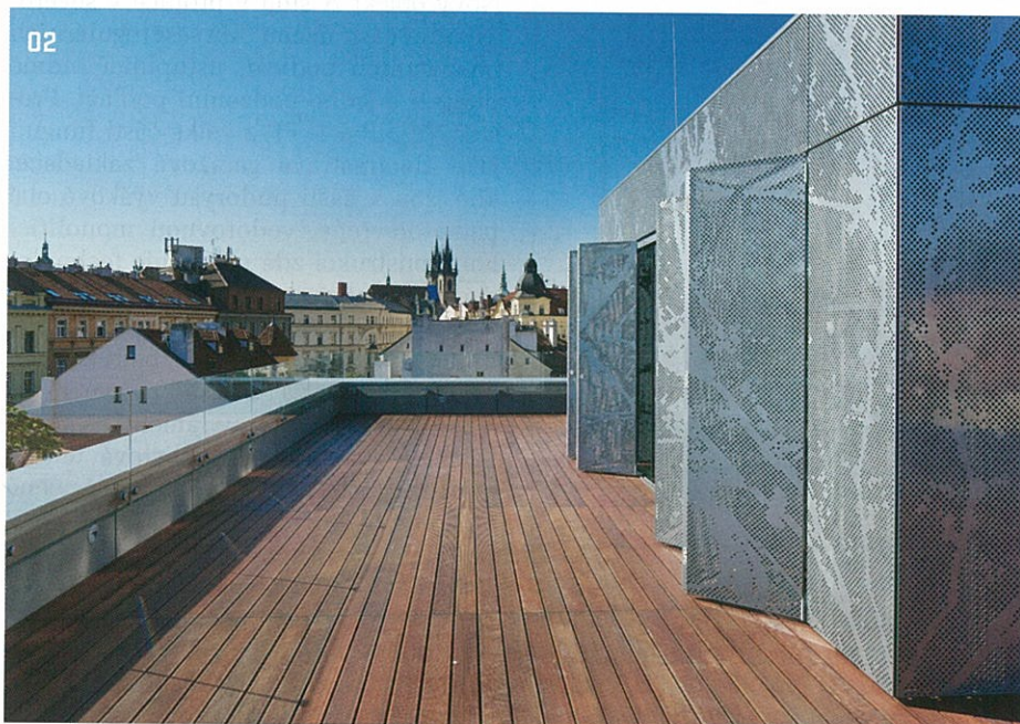
02 > Střešní terasa – zde se části fasád při otevírání skládají
