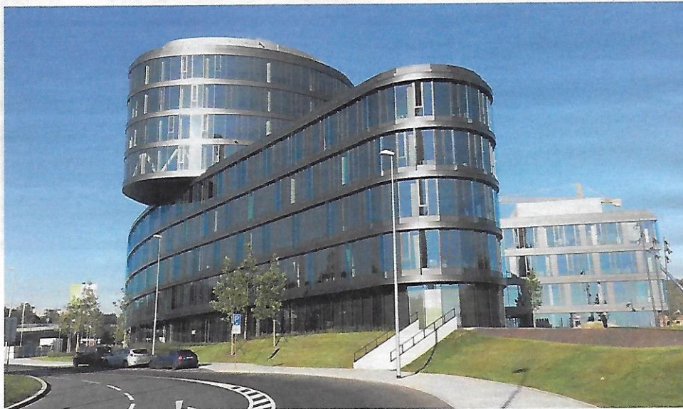
Transformace areálu Walter
