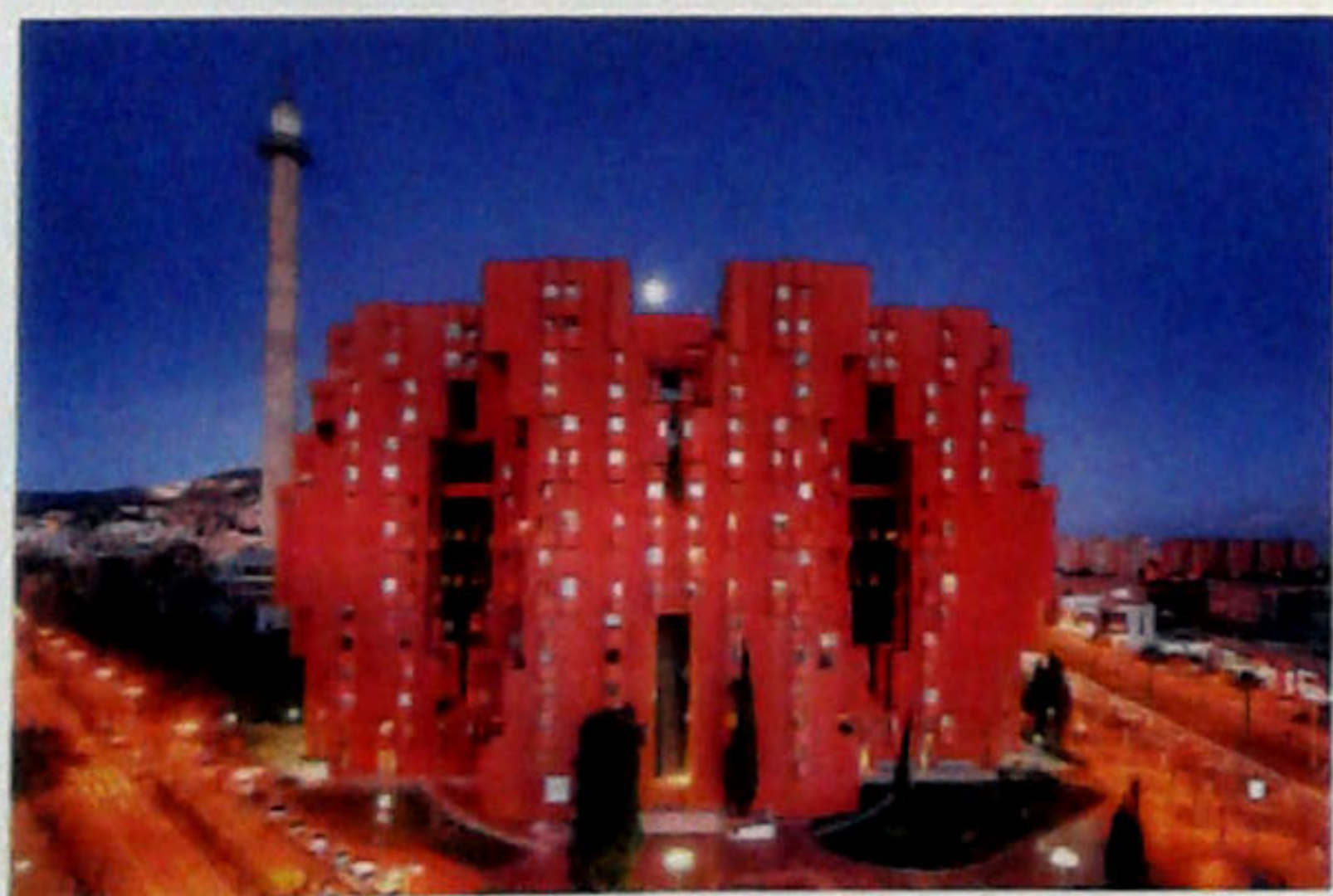
Bytový komplex Walden 7, důmyslné lidské termitiště pro tisíc obyvatel
