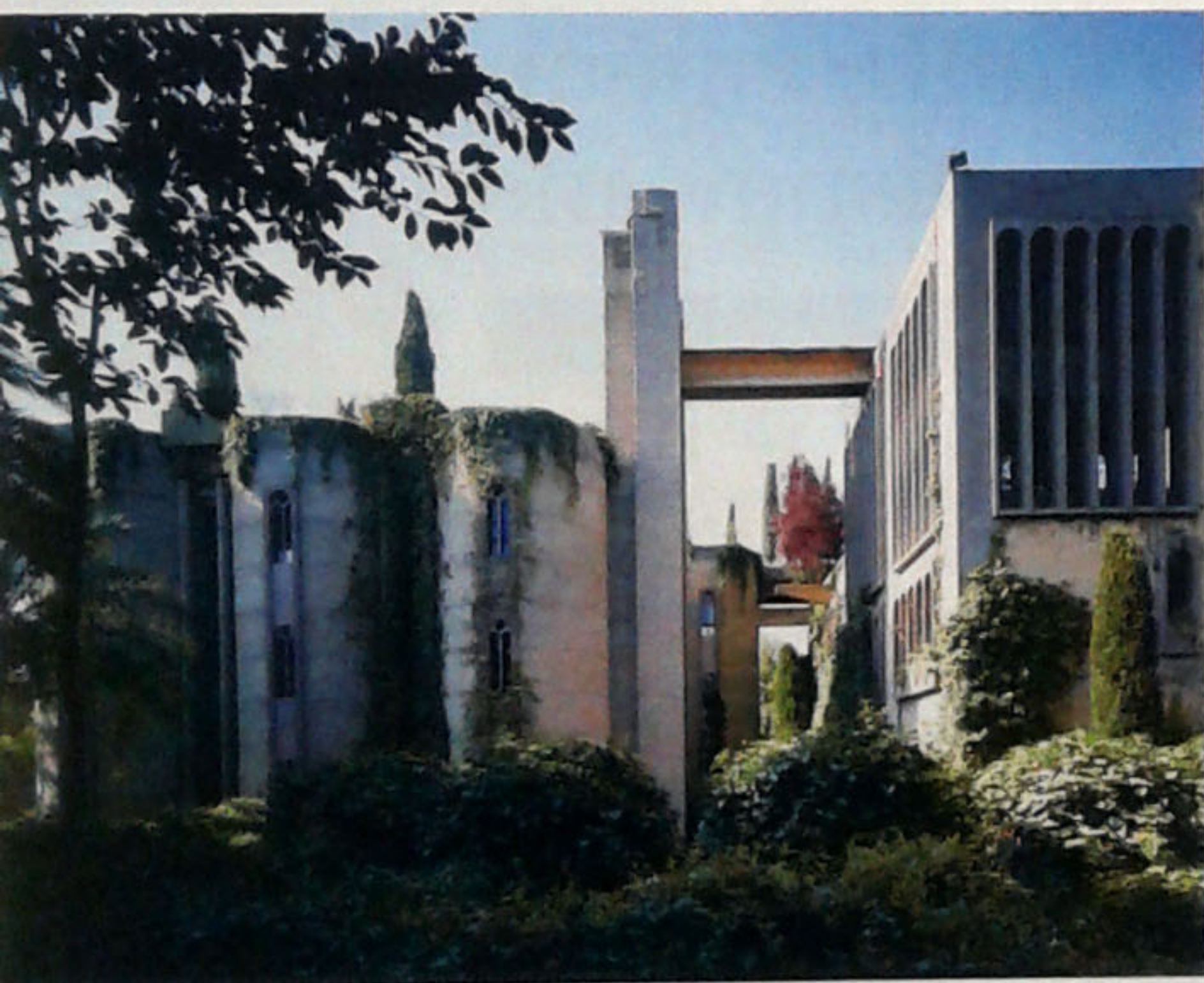
V levé části bývalé cementárny je ateliér, v pravé má Ricardo Bofill svůj apartmán, který nazývá katedrála
