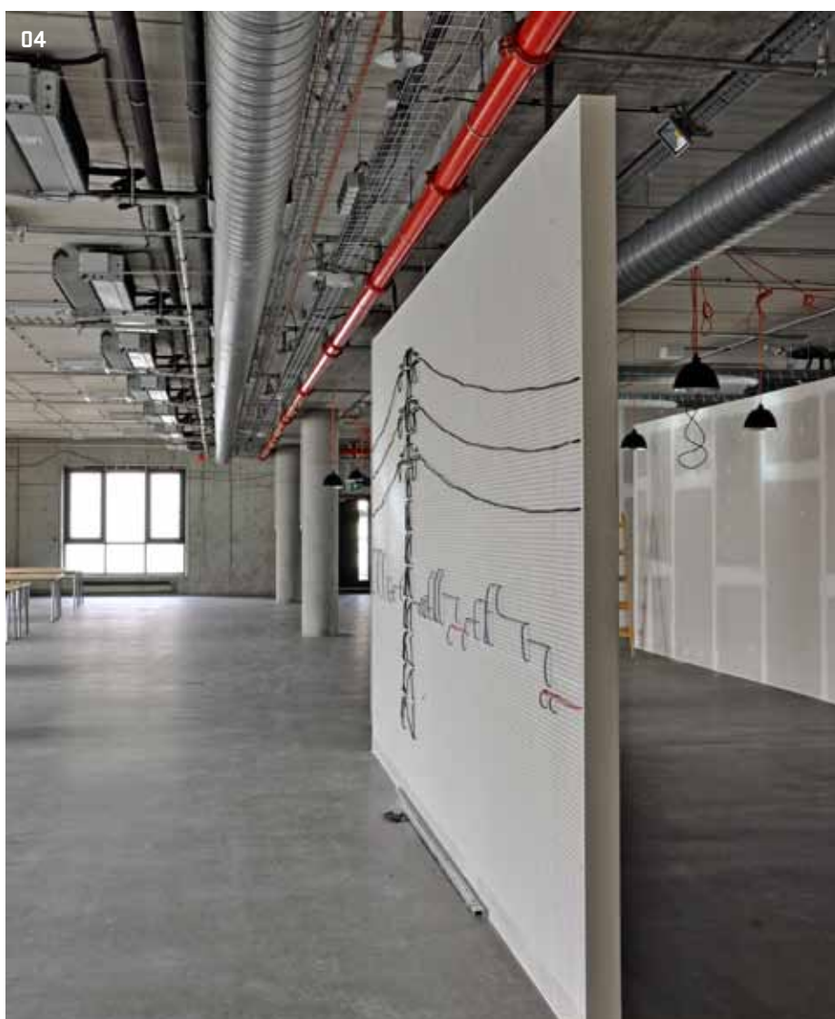
04 > Kdo říká, že nejde udělat volně stojící příčka v prostoru? Nahoře je do stropu zafixovaná závitovými tyčemi, všude po obvodu jsou UA profily, z jedné strany opláštěná děrovanými deskami Knauf Cleaneo, z druhé strany klasickými. Na první pohled je celá konstrukce v rozporu s obecnými montážními zásadami suché výstavby, ale přesto tu stojí, a hned na několika místech.
