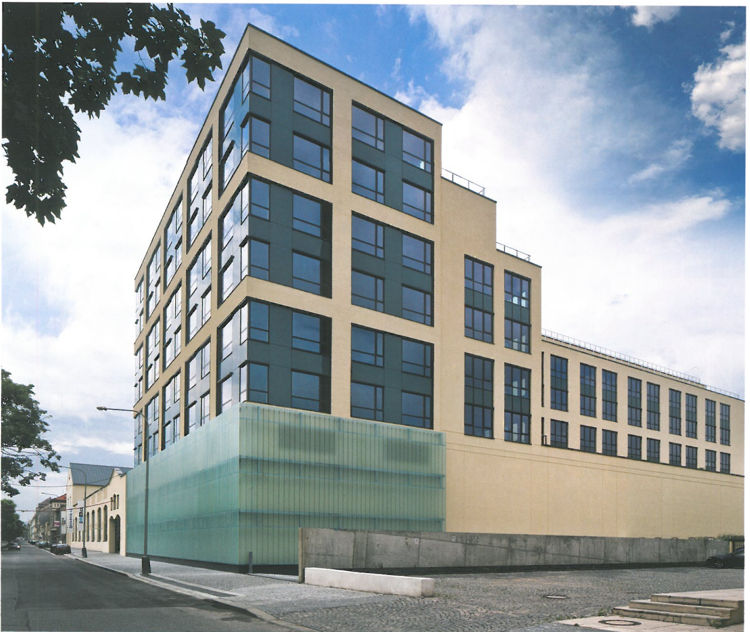
1 Polyfunkční objekt Forum Karlín – pohled od jihovýchodu; uliční průčelí a veřejně přístupnou část parteru kryje lehká předsažená fasáda; na ostatní fasády je použit zateplovací systém se strukturální systémovou probarvenou omítkou a hliníkovými okny.
