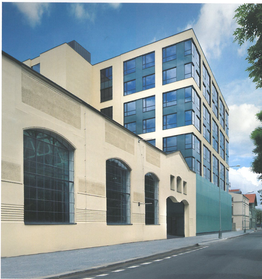
2 Novostavbu (2. etapa, vpravo) spojuje s rekonstruovanou halou (1. etapa, vlevo) pasáž ústící do Pernerovy ulice.
