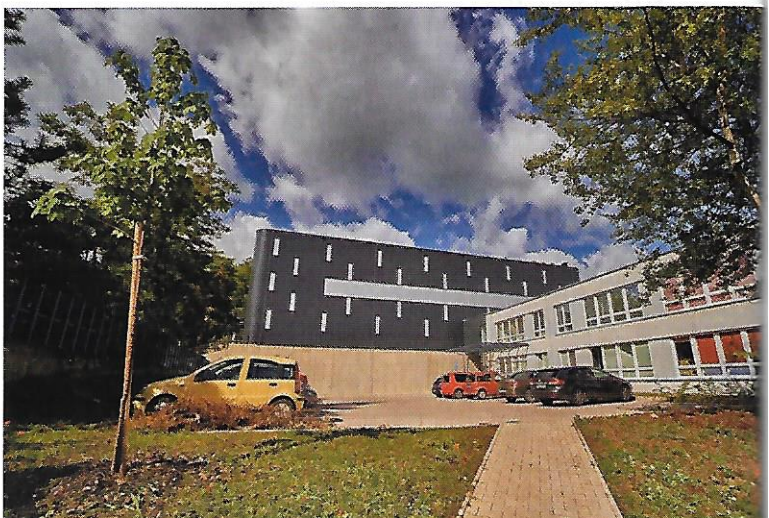
▼ Gymnázium Jana Palacha v Mělníku – výstavba tělocvičny
